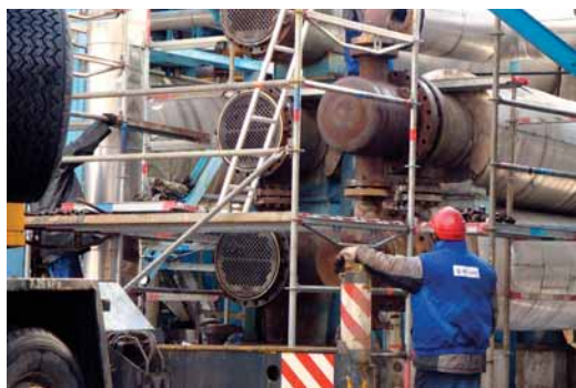
Vysokotlaké výměníky na PS40 HOSD vyžadují každoroční čištění. Manipulaci s nimi obstarává vyřadivák svazků (na snímku uprostřed).
