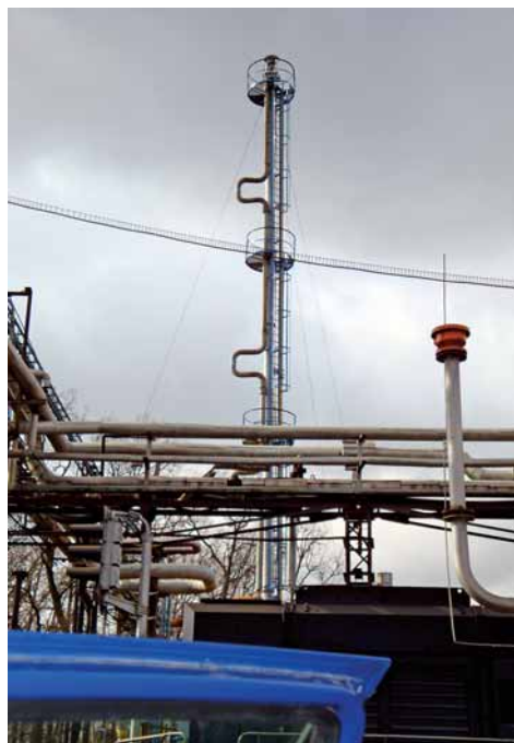
V průběhu provozní zarážky byl na fléře provozu AVDR vyměněn hořák. Na bezproblémovém běhu prací měl zásluhu i mechanik provozu Michal Ther.
