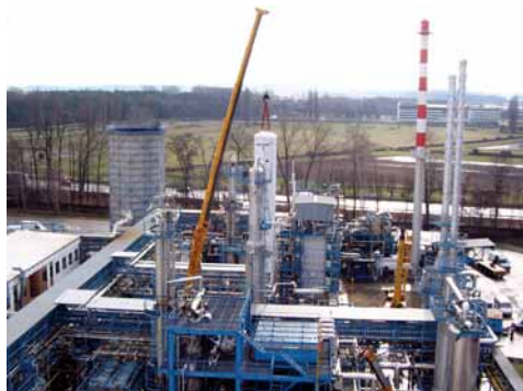
Separátor vodíku 41 S-01C musel být na pozici ustaven s pomocí mobilního jeřábu Liebherr 1200. Vyvažovací závaží pro tento jeřáb přivezl do podniku další kamion.
