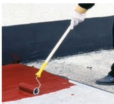
Application of SA 23 using roller.
