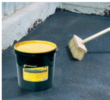
Gumoasfalt SA 12 is applied using mop or roller.
